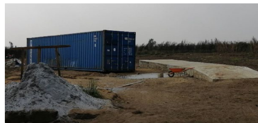
Construction d'une base pour poser le container arrivé en Juillet dernier
