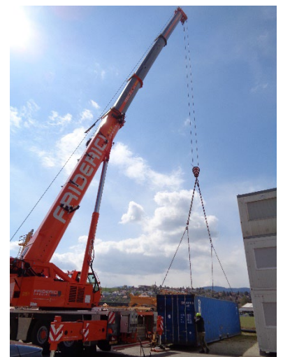
Heureusement que la grue est là pour charger les 12 tonnes de matériel!
